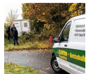
Die provisorische Heizung ist in dem Container links. FOTO: PRIVAT
